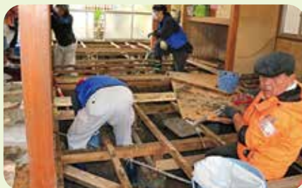
▲床下の泥出し作業
