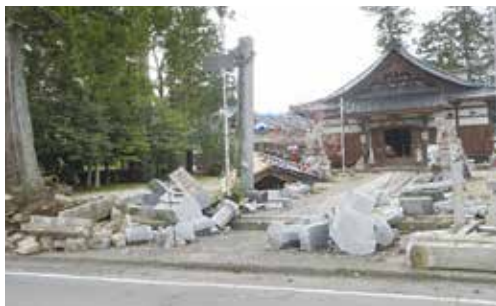
▲崩壊した鳥居と手水舎
